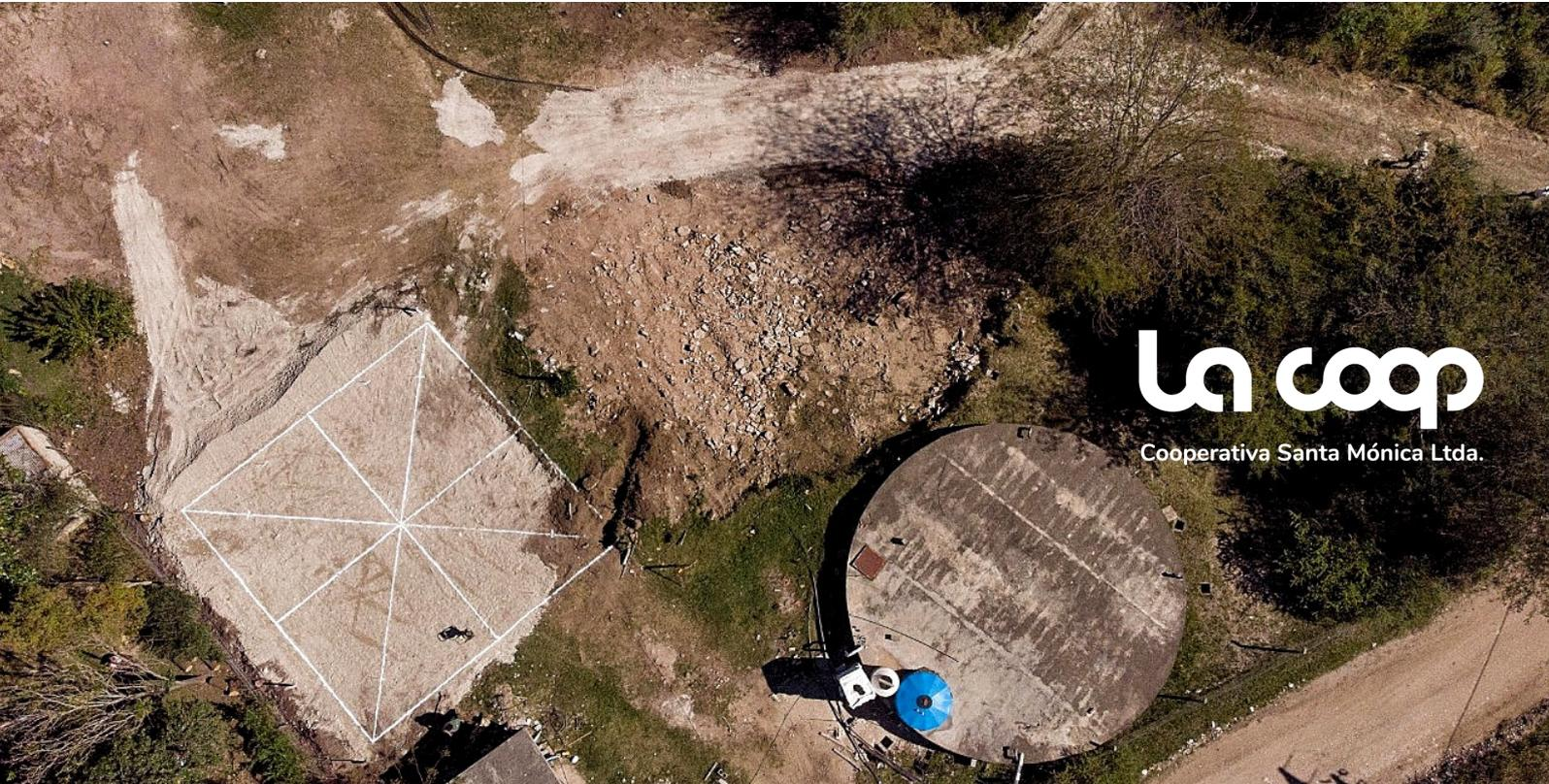
Las perforaciones previas a los pilotes fueron realizadas por los Sres Ricardo y Gastón Da Silva. La cisterna se montó sobre una platea -a cargo de la firma Maluvi, representada por Sr. Guillermo Floriano- con un sistema de placas preformadas, y techo de hormigón. Su capacidad es de 250.000 litros.
